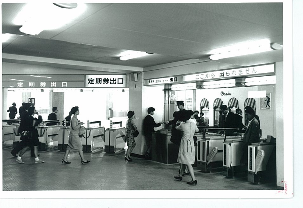
1967年3月阪急北千里駅にて世界最初の自動改札システムの営業運用を開始した (阪急電鉄(株)提供)
